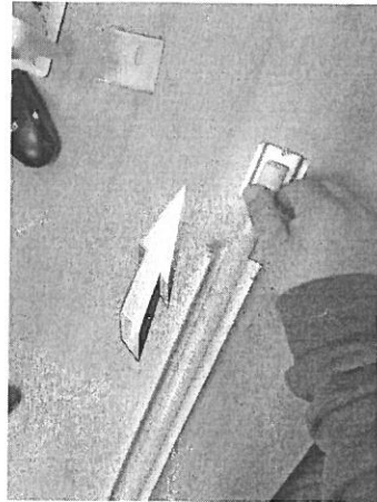
Slide out the fluorescent lamp. Τραβήξτε έξω την λάμπα φθορισμού
