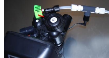
...SUL TUBO IN INGRESSO E RISPRISTINO SALAMOIA
