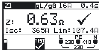
Abb. 5.35: Beispiel eines Ergebnisses der Leitungsimpedanzmessung
