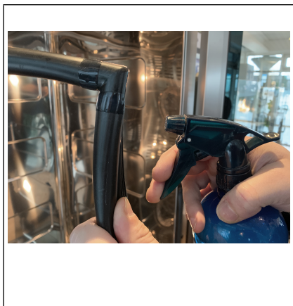
Figure: Préparer un nouveau joint
