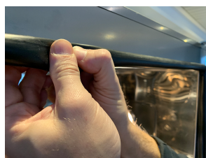
Figure: Toujours enfoncez le joint du centre vers l'extérieur
